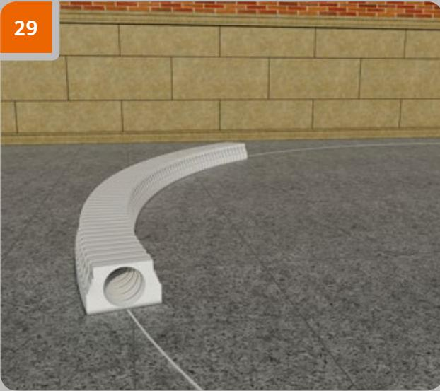
Разместить и зафиксировать элемент на ровной поверхности по заранее размеченному шаблону изгиба.
