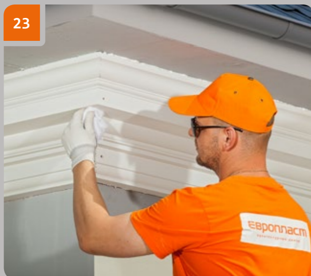
Протереть стык тканью, смоченной ацетоном.
