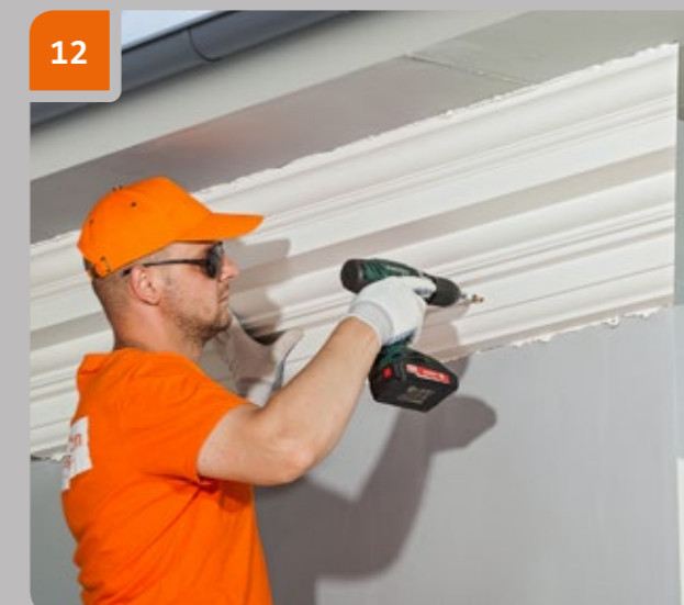
12 При помощи шуруповерта углубить шляпку дюбель-гвоздя в изделие на 2 мм.
