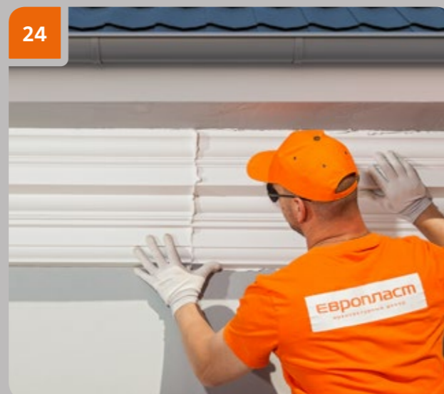
Продолжить монтаж следующего изделия.
