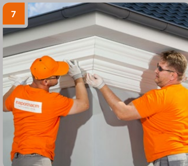
7 Проверить совмещение рисунка и профиля изделий.
