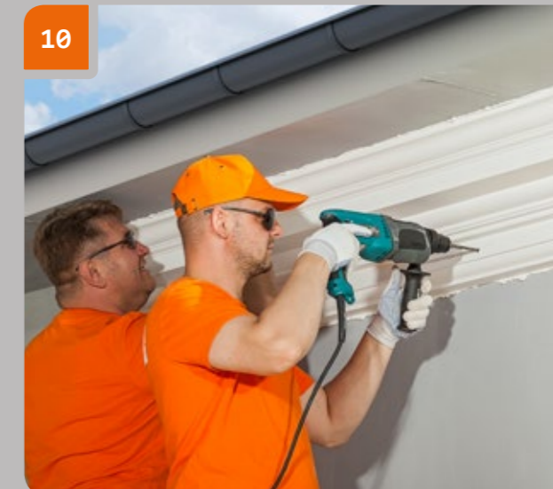
10 При помощи перфоратора, сделать отверстия для крепления изделия дюбель-гвоздями с шагом ≈600 мм.
