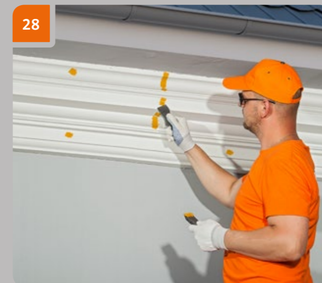
Зашпаклевать обработанные стыки и места заглубления саморезов автомобильной шпаклевкой.
