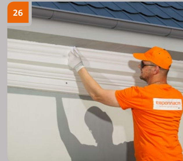
Удалить излишки клея тканью, смоченной ацетоном.
