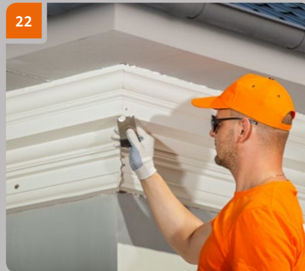
Сразу после приклеивания удалить выступившие излишки клея шпателем.
