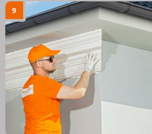
9 Приложить изделие к месту установки согласно разметке на стене. Прижать изделие по всей длине, чтобы клей выступил из-под всей плоскости примыкания.
