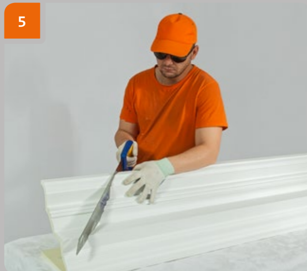
5 С помощью ножовки завершить распил.
